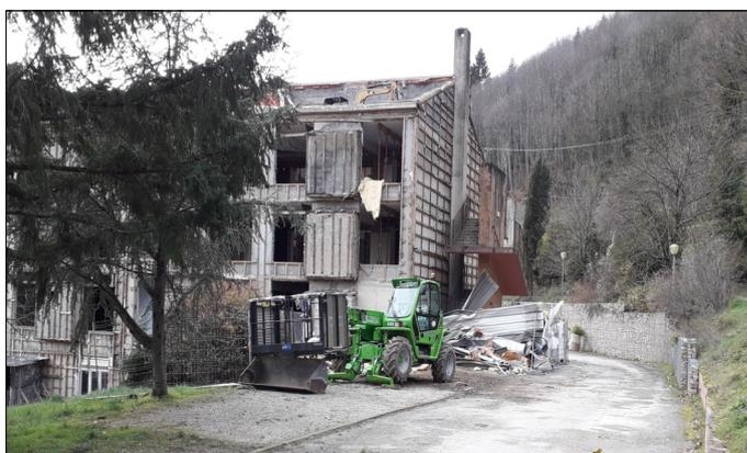
La déconstruction intérieure et extérieure se poursuivant, il faut en parallèle mettre rapidement le bâtiment hors d'eau en assurant l'étanchéité du toit et en posant les menuiseries extérieures .
